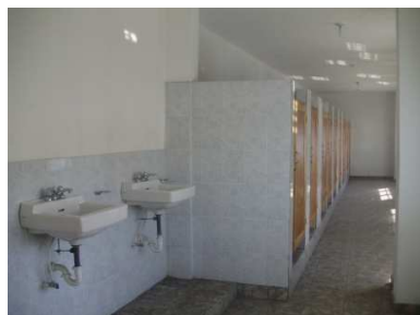
Toilettes Publiques reliées à 1 unité biogaz écologiquement
