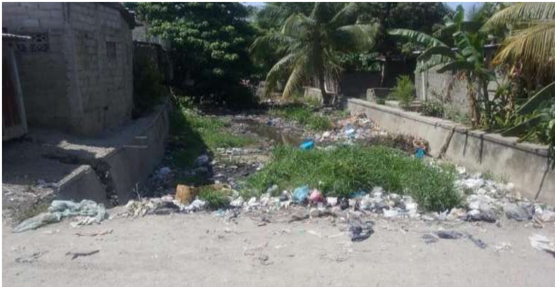
Figure 3-8 : Photographie de la Rivière du Commerce endiguée à l'Est de la Route National 3
