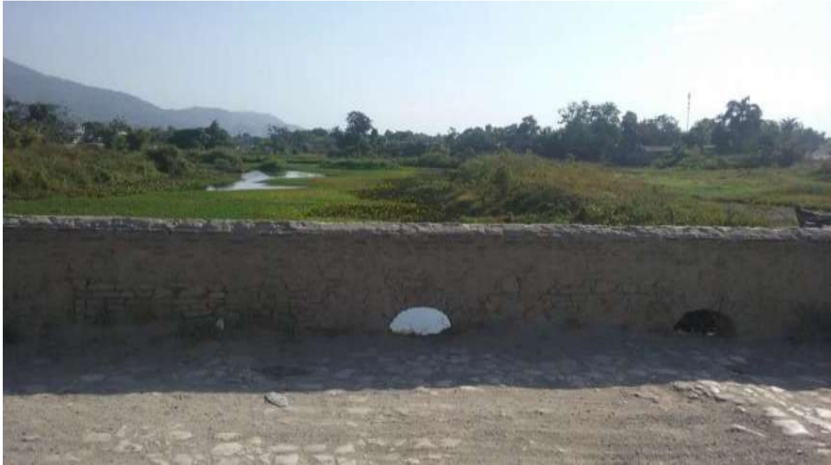
Figure 3-12 : Photographie du Pont colonial, Rivière du Haut du Cap
