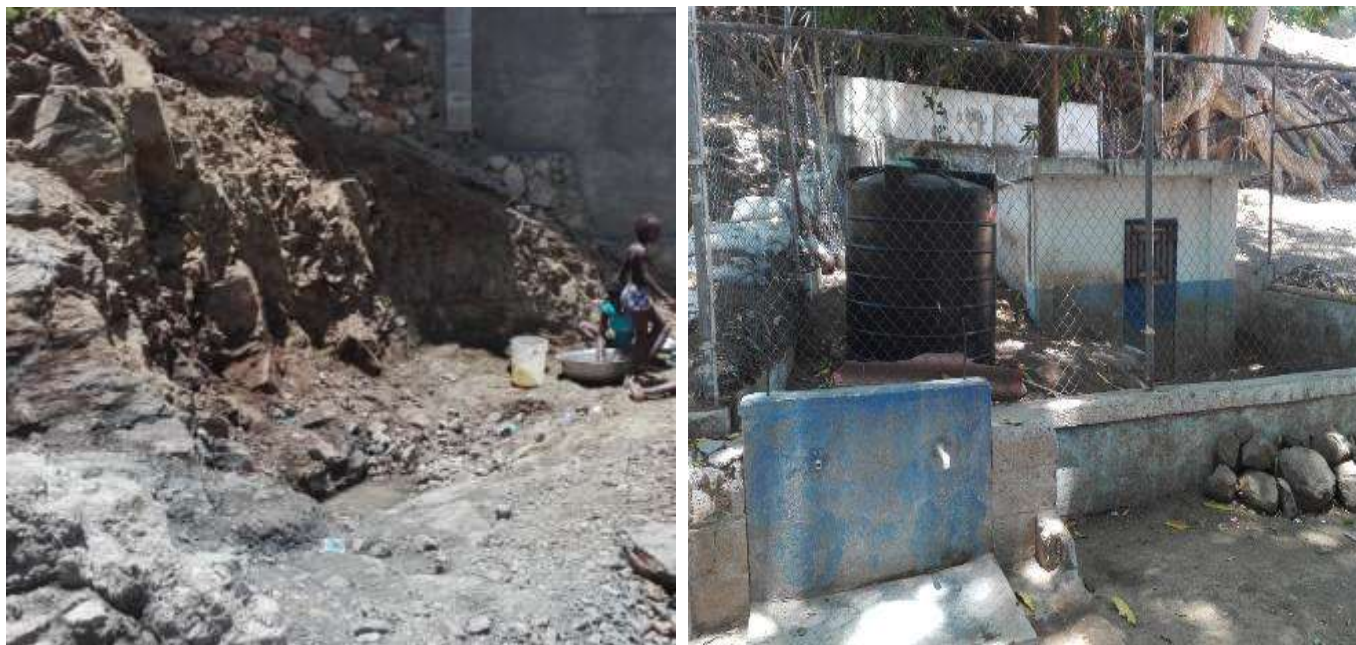
Figure 3-5 : Photographies, à gauche :Source Baziko non captée, à droite : Source Boileau captée.
