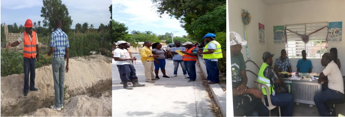
Photos d'accompagnement des travaux et de réunion avec la Firme concernant les activités
