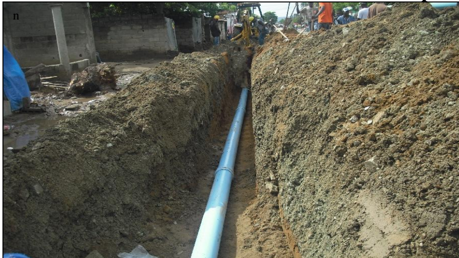
Le Chantier de Ouanaminthe
