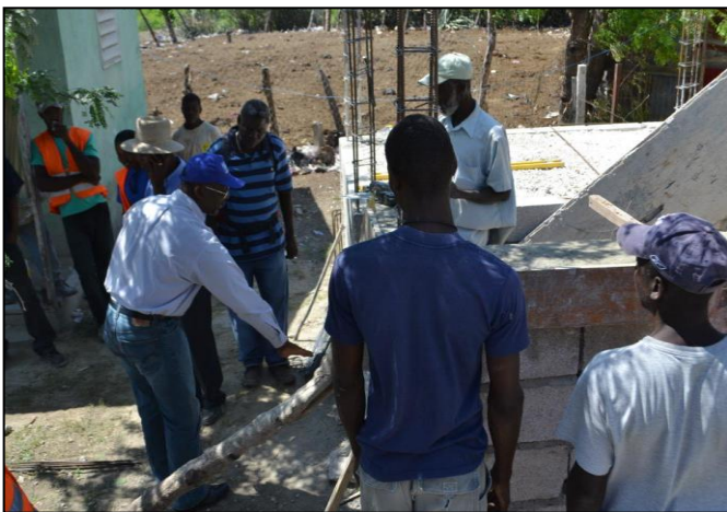
Supervision des travaux en cours à Merger
