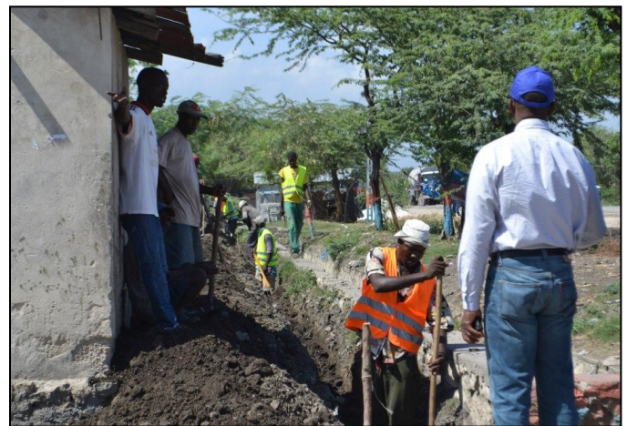
Visite de chantier du Directeur Général de la DINEPA
