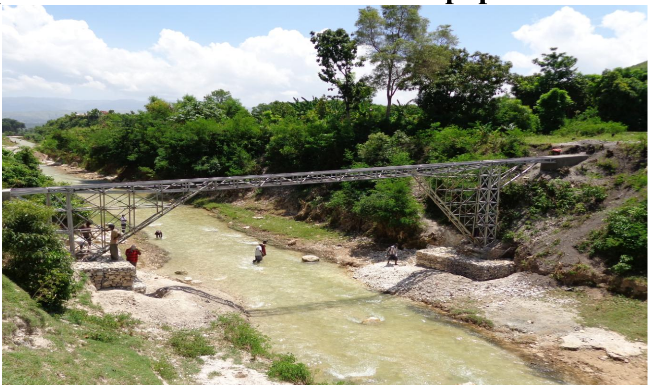
Structure métallique utilisée pour assurer la traversée de la rivière par la conduite d'adduction à Verrettes
