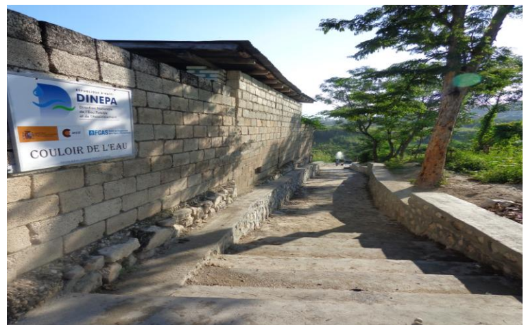
Le couloir de l'eau - un accès amélioré en maçonnerie vers les fontaines situées au bord de l'eau
