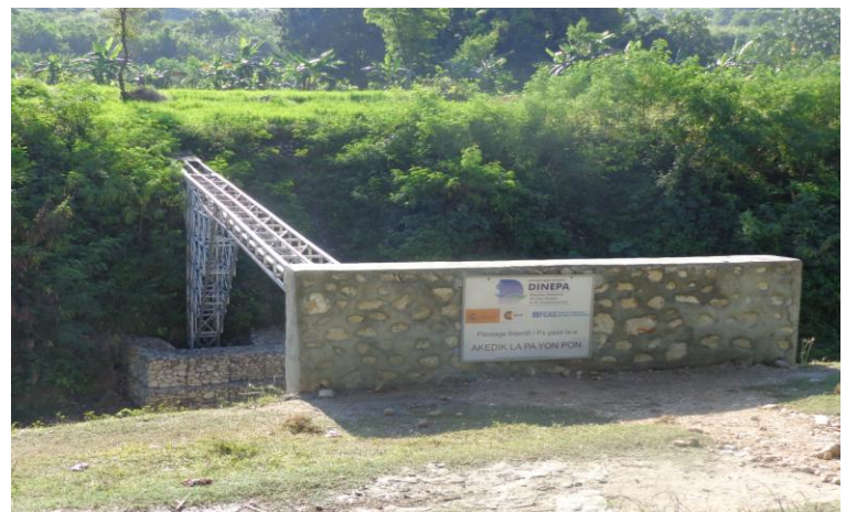
Vue latérale de l'Aqueduc
