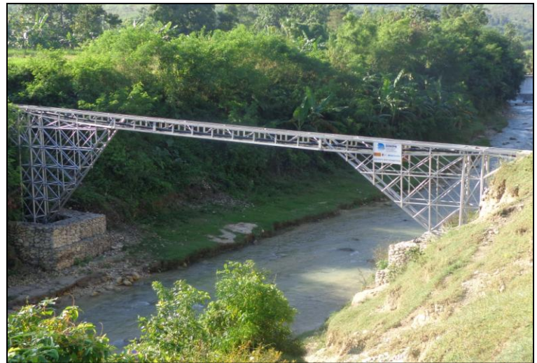
Vue de l'Aqueduc qui fait la traversée de la rivière des Verettes
