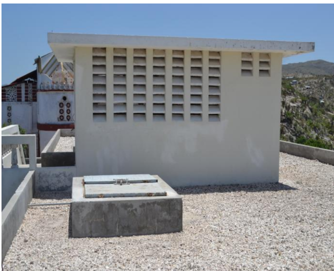
La salle de chloration sur le toit du réservoir vue de l'extérieur
