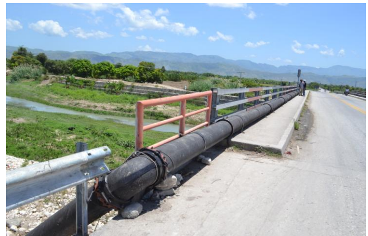
Vue de la conduite de refoulement traversant le Pont Gaudin
