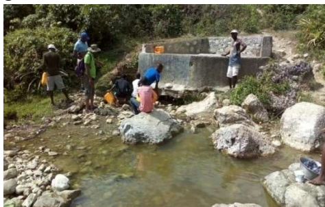
Vue du captage de la source Tikreson
