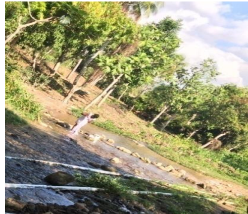
Zone de construction du ponceau
