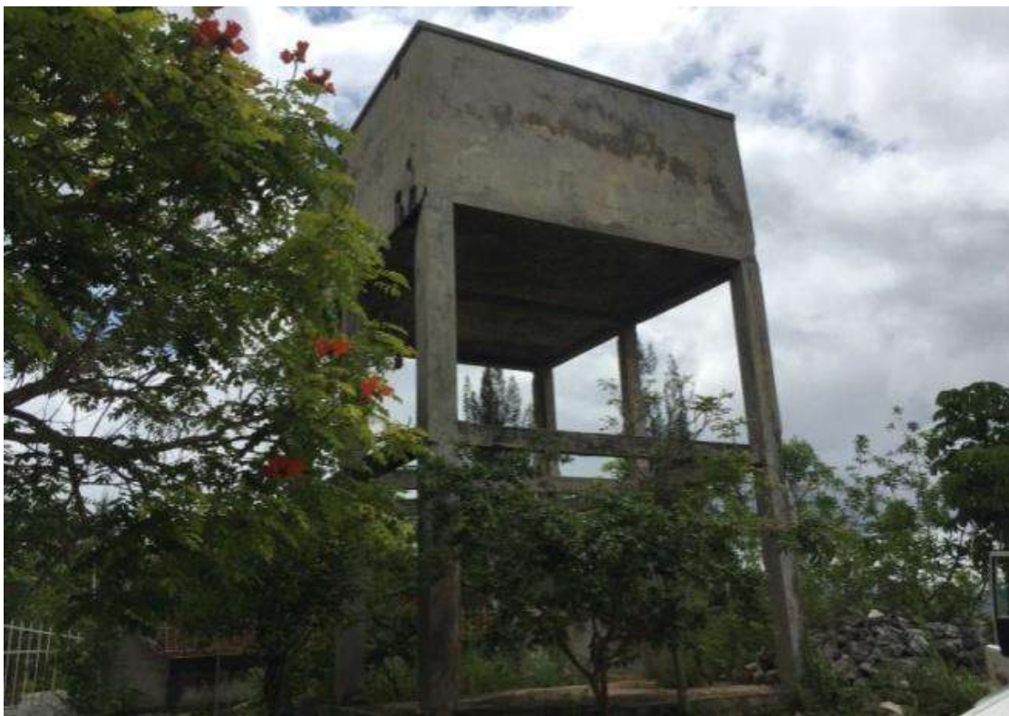
Figure 2: Le réservoir Ternier à démolir est proche des résidences privées. Si aucune précaution n'est pas prise une perturbation de la quiétude des usagers (bruits, vibration, poussière) risque d'être observée lors des activités de démolition. L'accès doit être garanti en toute sécurité par l'entrepreneur pour éviter des accidents, une signalisation correcte doit être aussi envisagée lors des travaux et toutes les personnes concernées doivent être informées avant les activités de démolition.
